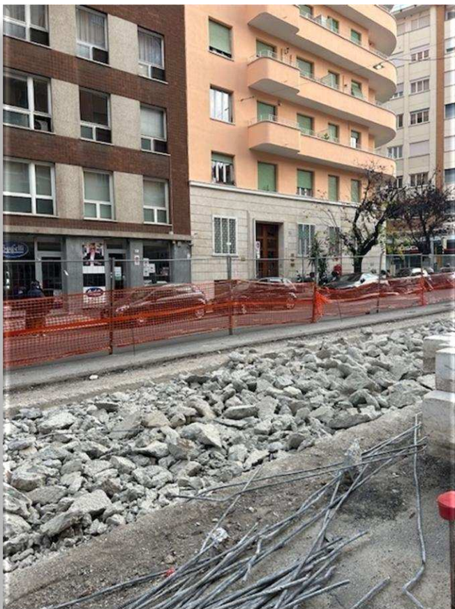
Rimozione della pavimentazione
