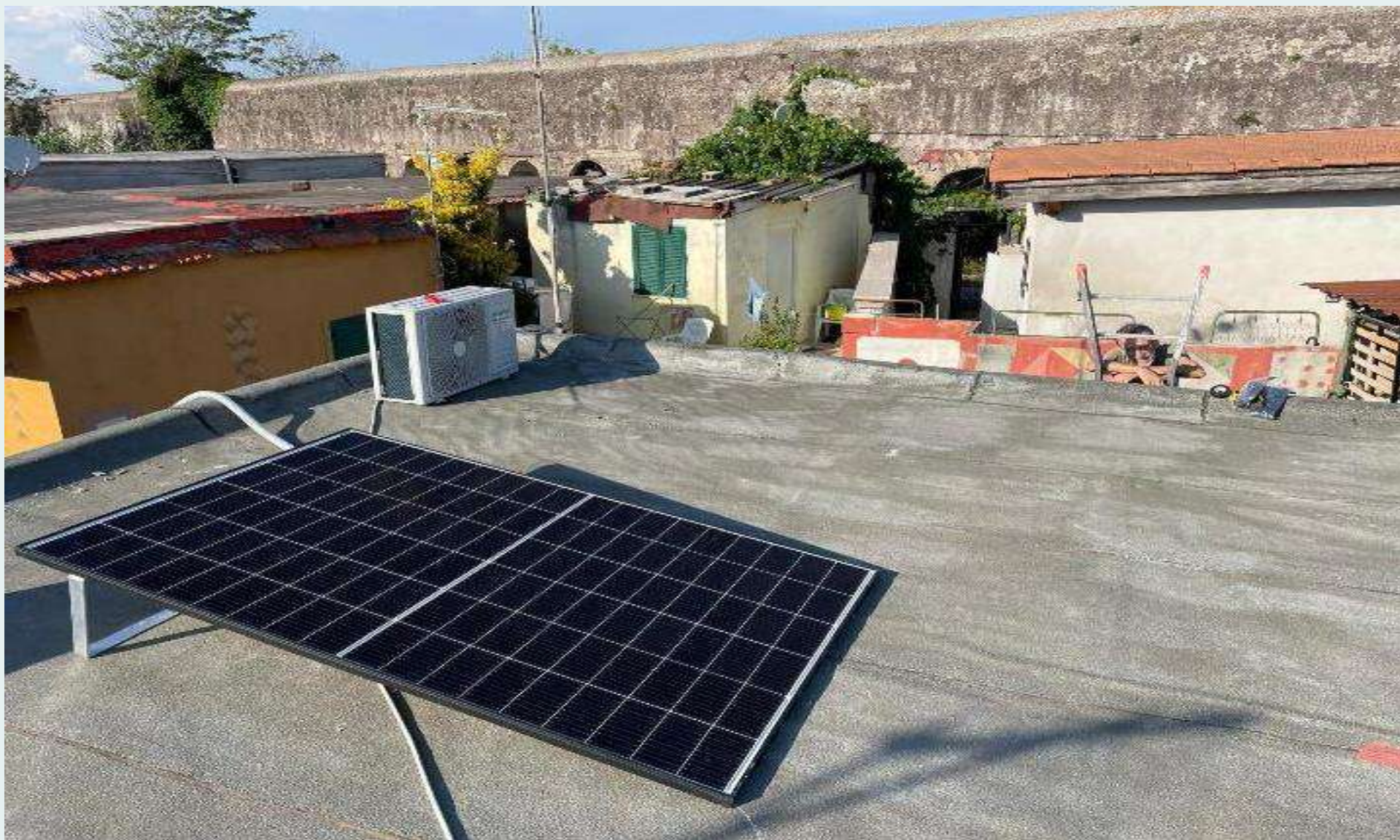
Impiantino fotovoltaico semplificato Plug&Play. Modulo da 420 Wp, inverter 350W. Può ridurre di un quinto la bolletta elettrica.
