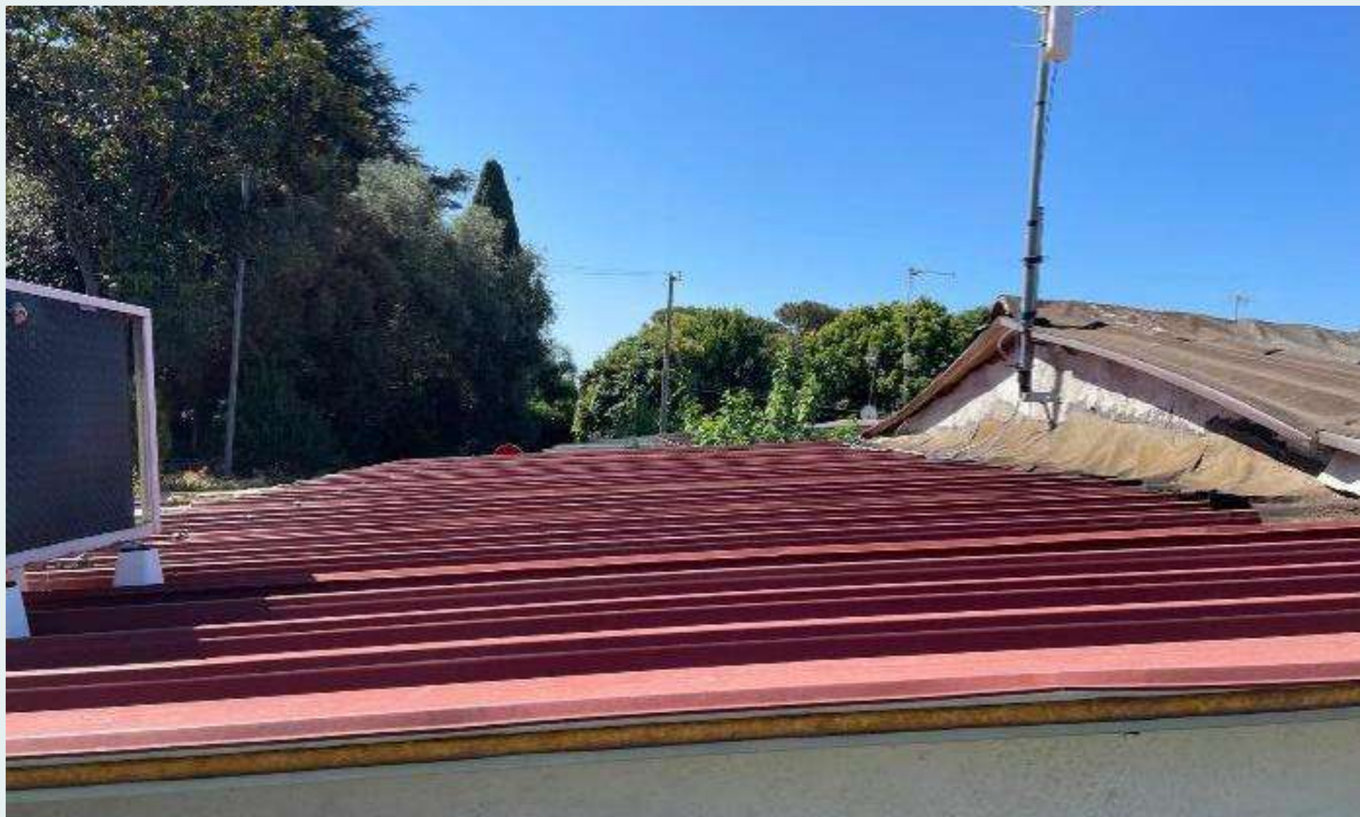
Pannello sandwich di tipo industriale. Non calpestabile.
