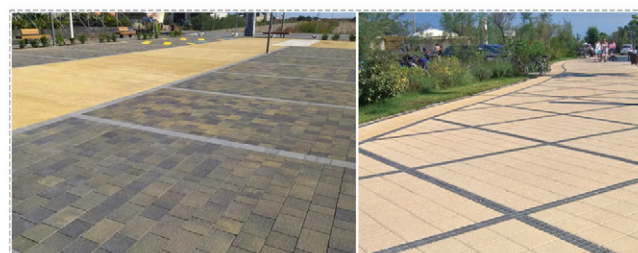
Esempi di applicazione di pavimentazione in masselli autobloccanti filtranti . [https://www.betonella.it/]
