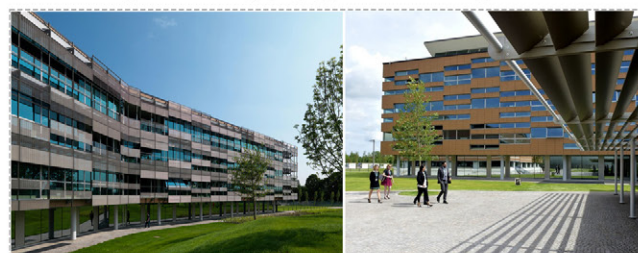
Realizzazione delle pavimentazioni esterne con Betonella® FUTURA per l'ampliamento dell'Headquarter Banca Crédit-Agricole (Parma). [https://www.betonella.it/]
