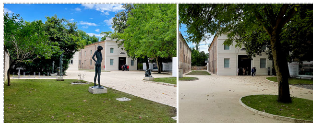
Realizzazione del piazzale e parcheggio in conglomerato ECOpav presso il Museo Michelangelo Antonioni di Ferrara. https://evizero.com/
