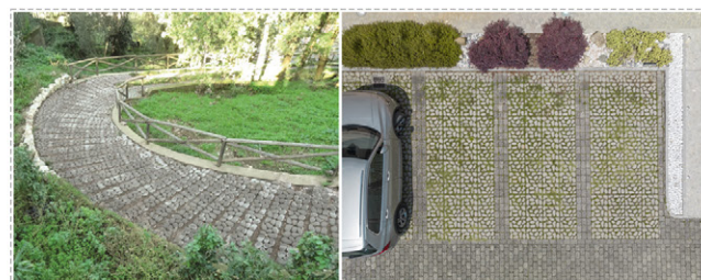
Esempi di applicazione di pavimentazione in lastre drenanti fotocatalitiche. [https://www.paver.it/]
