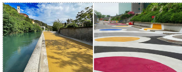
Esempi di applicazione di pavimentazioni in conglomerato bituminoso colorato
